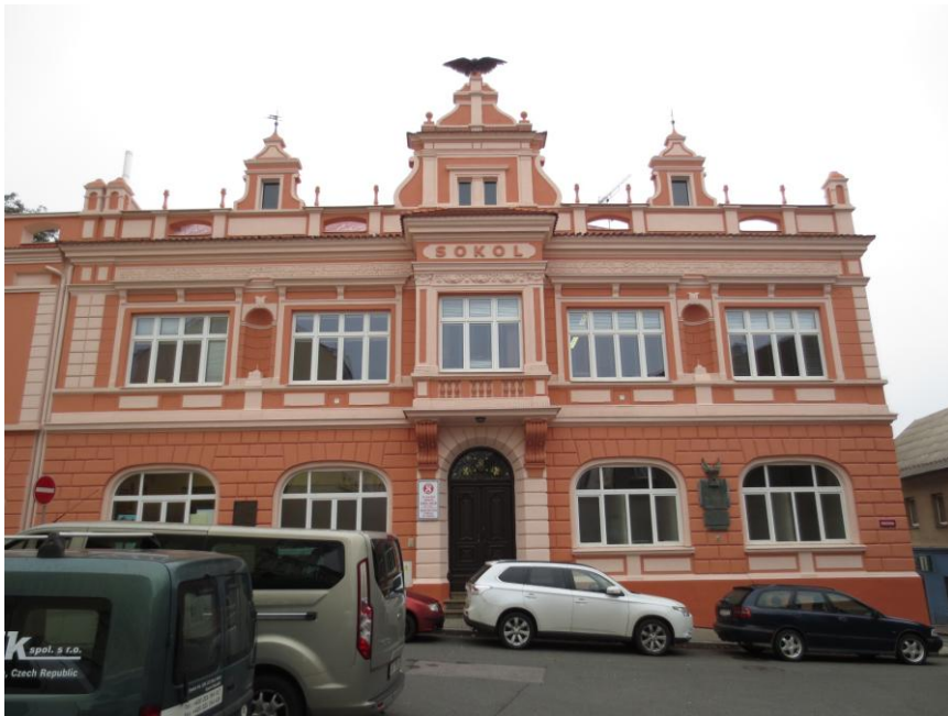
1. Kolínská sokolovna nám moc radosti nepřinesla, ale máme před sebou ještě téměř celou soutěž, i když soupeři jsou velmi zdatní.
